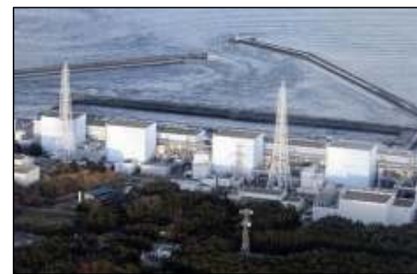
福島第一原子力発電所 2011年
